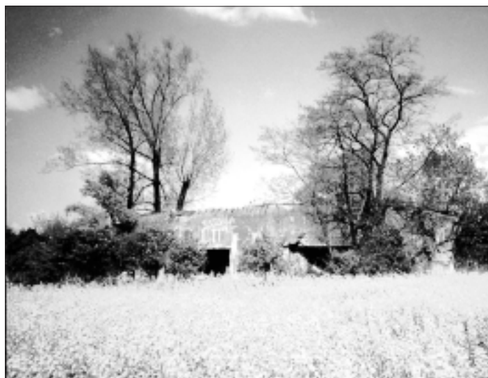
Dvoupodlažní velký bunkr OP-S 11 u Malých Hoštic pro čtyřicet dva mužů
