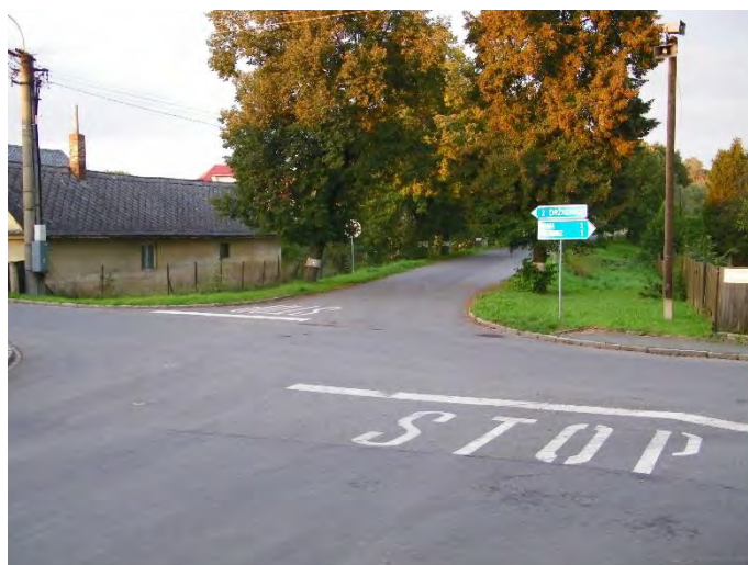
Na křižovatce Jantarová × K Celnici přibylo nové vodorovné značení
