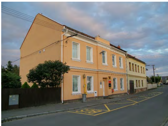
Opravený dům služeb
