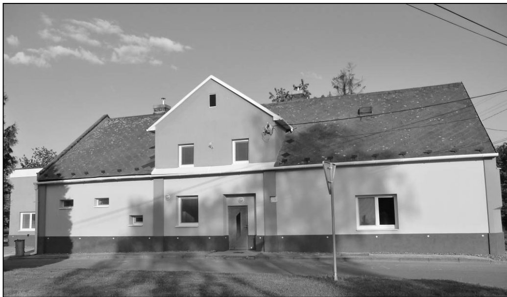
U Kulturního domu v Držkovicích jsme dokončili sokl .
