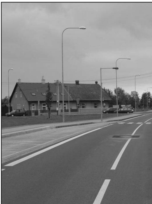
Na žádost občanů jsme nechali opravit tři propadlé poklopy na Vávrovické ulici na Karlovci u mrazíren Nowaco.
