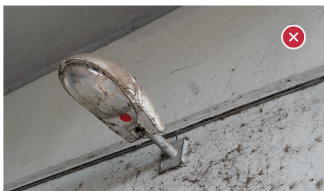
Silně znečištěná nebo zarostlá svítidla nemohou dobře plnit svojí funkci
