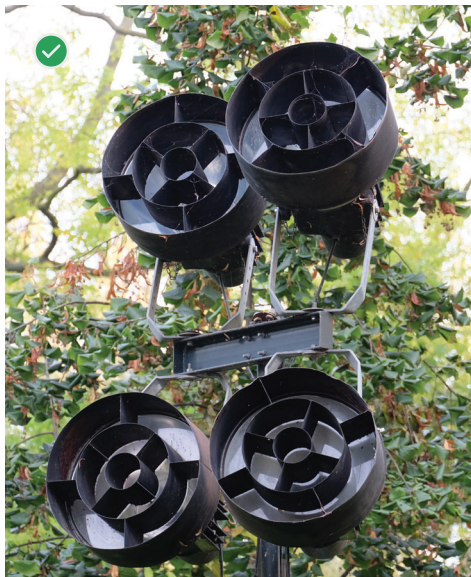
Světelné znečištění způsobené světlotrasy lze snadno omezit technickými doplňky
