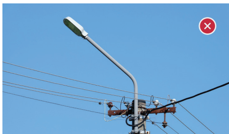
Naklání svítidel je špatná praxe, způsobující zbytečné světelné znečištění
