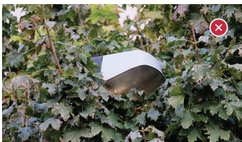
Naklání svítidel je špatná praxe, způsobující zbytečné světelné znečištění
