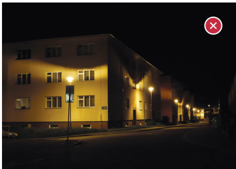
Příklad špatného veřejného osvětlení: Velká část světla směřuje do oken obytných domů, zatímco přilehlá komunikace je osvětlená nedostatečně
