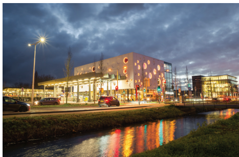
Obchodní centrum a kancelářské budovy
