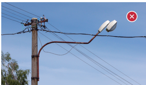
Naklání svítidel je špatná praxe, způsobující zbytečné světelné znečištění
