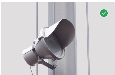
Světelné znečištění způsobené světlotrasy lze snadno omezit technickými doplňky
