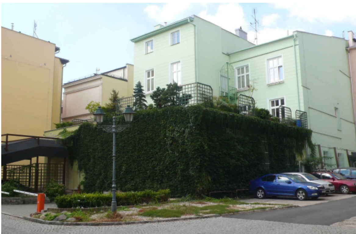
Zelená stěna – centrum města, ulice Růžová. V centru Opavy, které je označováno obyvateli jako přehřáté, se nachází řada menších či větších ploch porostlých zelení, která budovy ochlazuje. Nejčastěji je využíván břečťan nebo přísavník trojlaločný. Měřením bylo prokázáno, že teplota této zelené fasády je o několik stupňů nižší než teplota běžné fasády.
