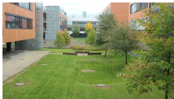
Povrchové vsakování dešťové vody pomocí zasakovacích průlehů a rýh mezi pavilony kampusu Masarykovy univerzity v Brně-Bohunicích. (zdroj: www.tzb-info.cz)
