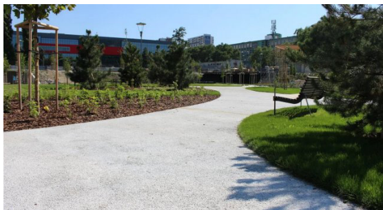
Chodník z vodopropustného betonu v parku Jama v Bratislavě (zdroj: http://www.stavebnictvi3000.cz )
