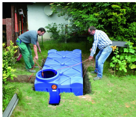
Instalace podzemního zásobníku k jímání dešťové vody
