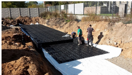
Instalace zasakovacích boxů v Rosicích
