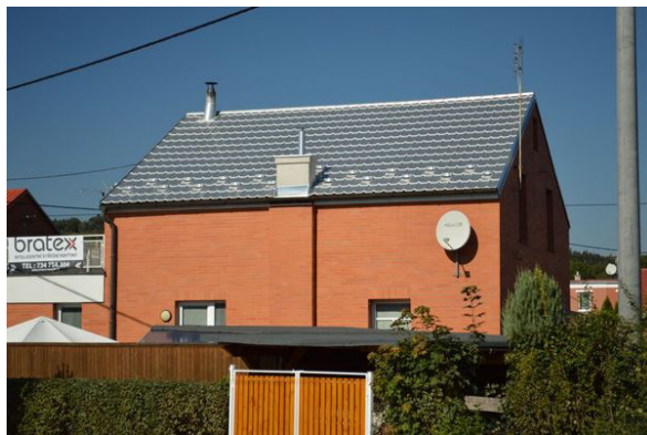
Bílá kovová střecha české produkce (zdroj: www.krytiny-strechy.cz )
