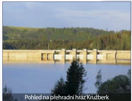
Pohled na přehradní hráz Kružberk
