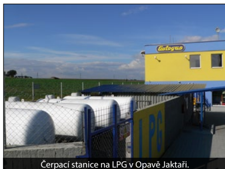
Čerpací stanice na LPG v Opavě Jaktáři.
