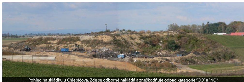
Pohled na skládku u Chlebičova. Zde se odborně nakládá a zneškodňuje odpad kategorie "OO" a "NO".
