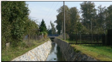
Prohloubený a opevněný Otický příkop v zastavěné části města v Opavě-Kylešovicích je opatřením proti povodni. Ve volné krajině by k takové totální fixaci toku nemělo docházet.
