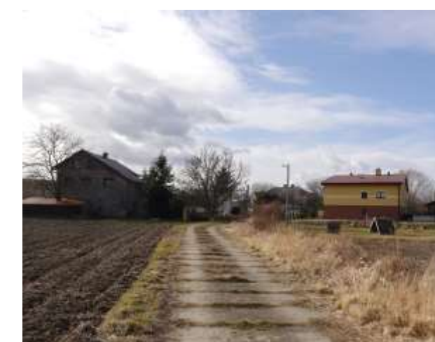
Odvodňovací příkop podél panelové cesty
