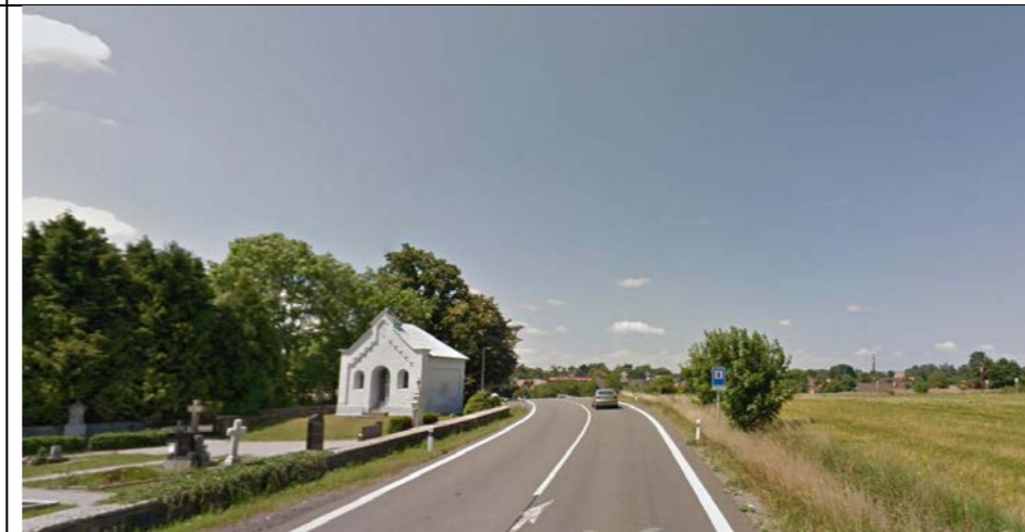
PŘÍJEZD DO SÍDLA PO SIL. I/46 OD VÝCHODU
