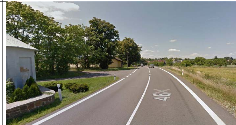
SOUČASNÝ STAV, DETAIL VJEZDU
