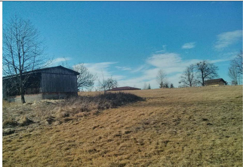
SVAŽITÝ TERÉNU, POHLED Z JIHU, STAVBA K ODSTRANĚNÍ
